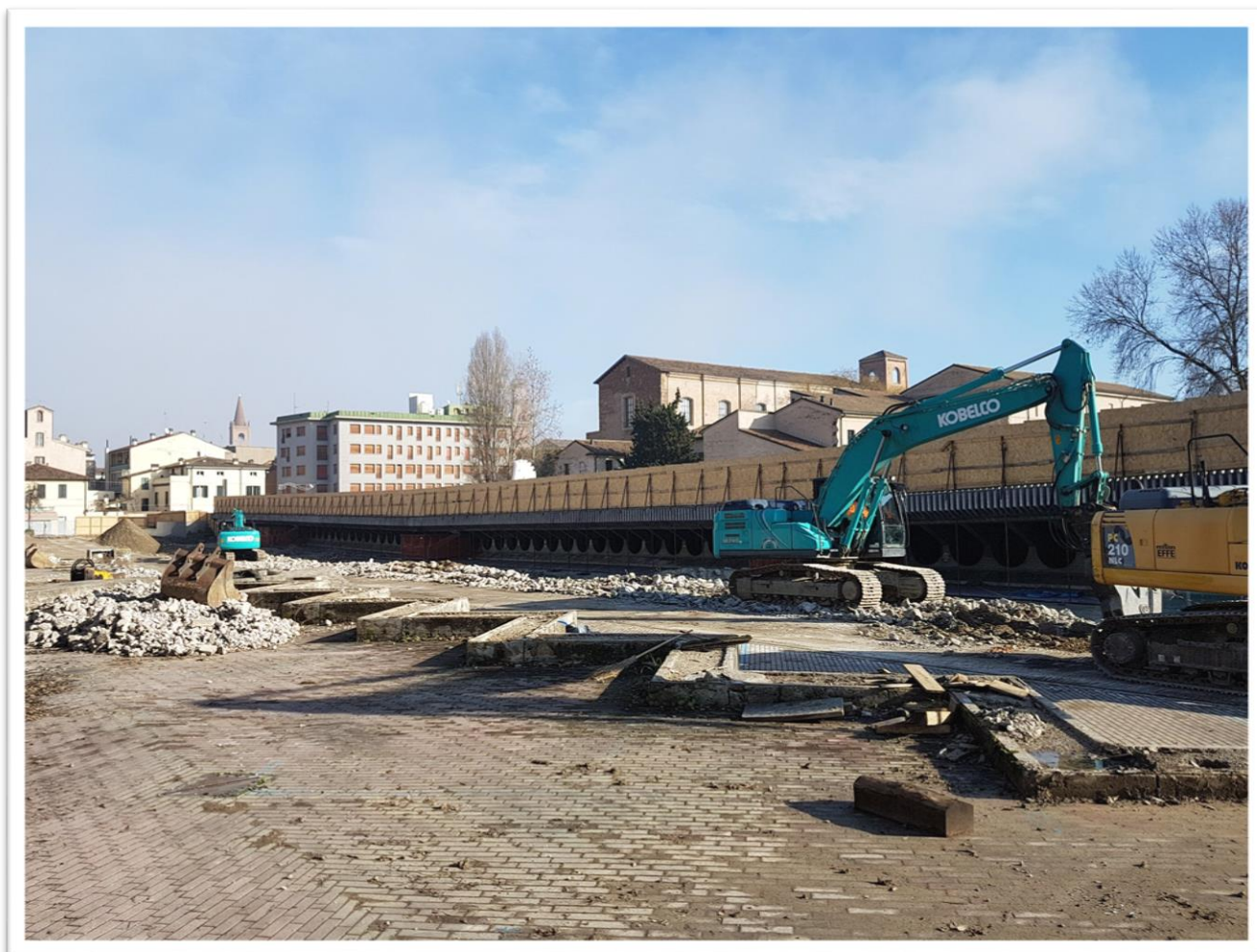
De-sealing in corso a Forlì
